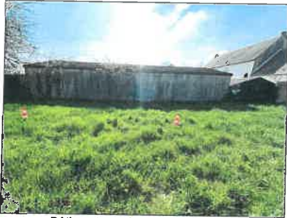
Bâtiments avoisnants au Sud-est
