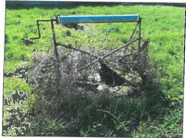
Puits existant au droit du projet
